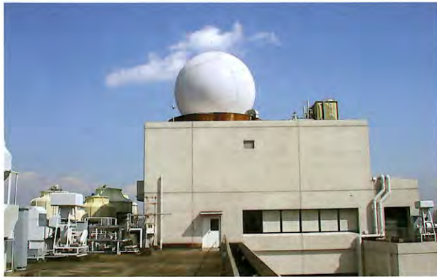
気象研究所本館屋上の二重偏波ドップラーレーダー (気象研究所提供)
