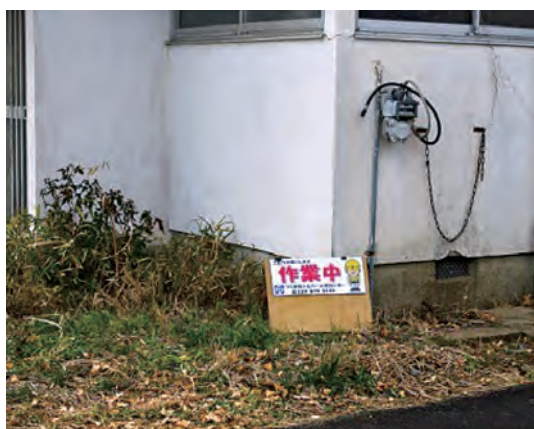
「作業中」と表示して調査を実施
