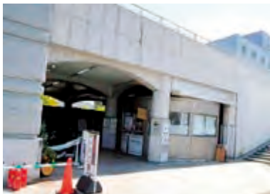
駐輪場事務室
